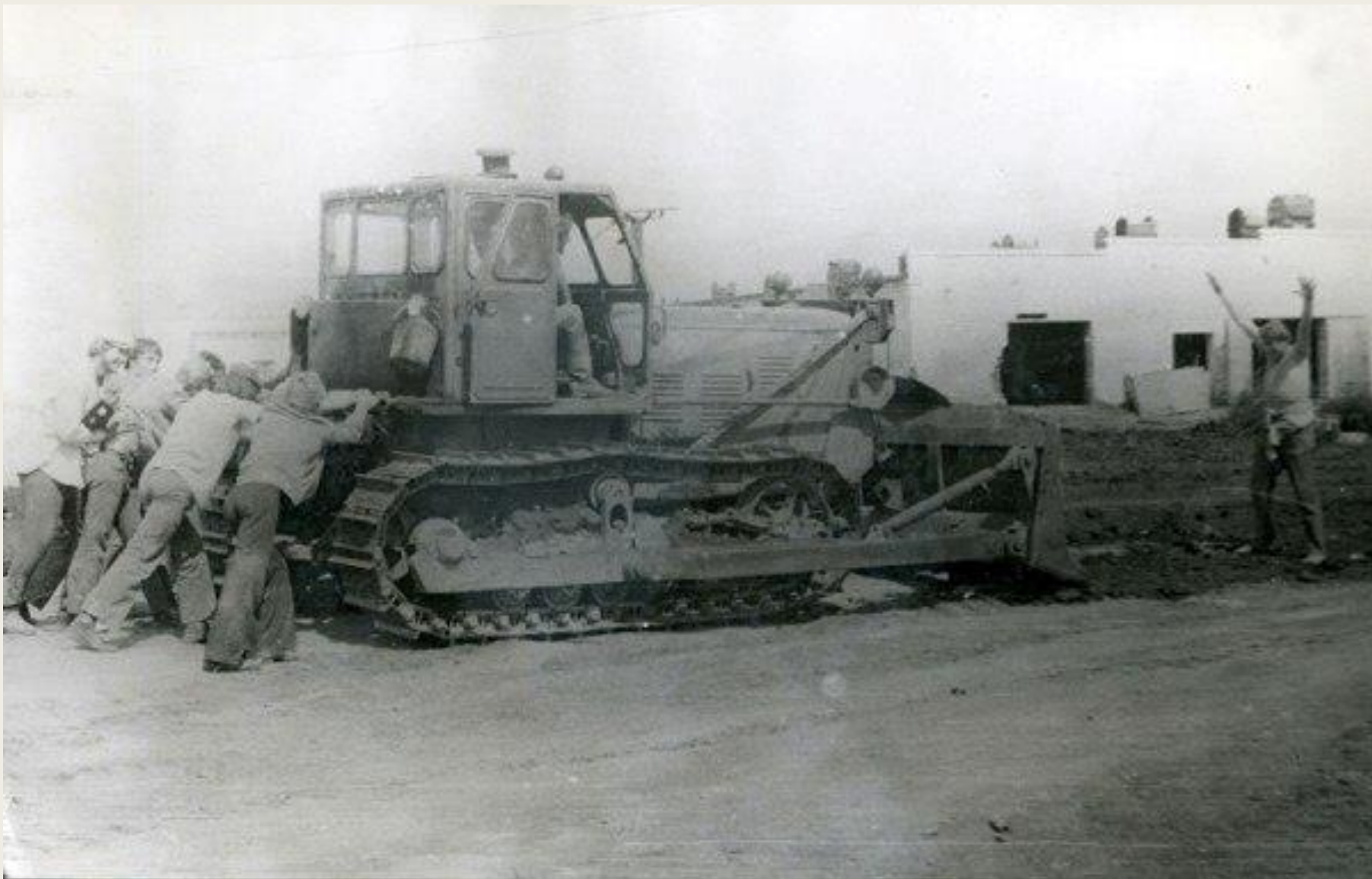
1981 г. - стройотрядовцы ТИХМа на строительстве коровника.
