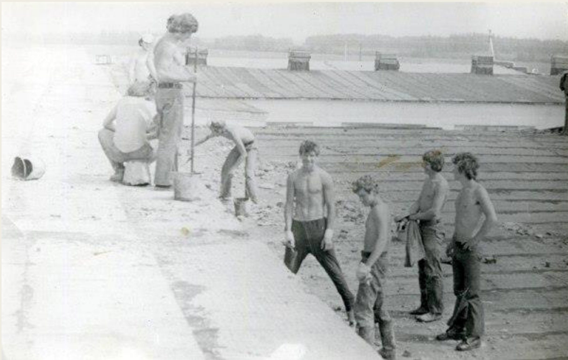
1981 г. Стройотрядовцы ТИХМа.
